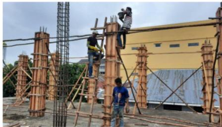
**Gambar 2.6** Pekerjaan Kolom
