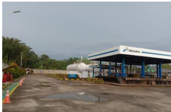
Gambar 4.5 Tempat Operasional Gas
