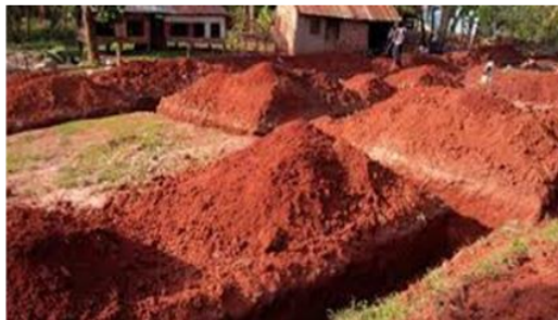
Gambar 2.2 Pekerjaan Tanah dan Pasir
