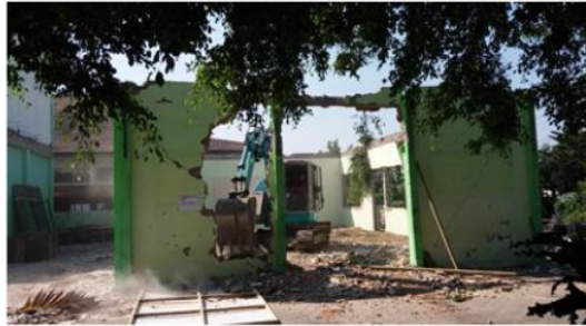
Gambar 2.1 Pembongkaran Gedung Lama
