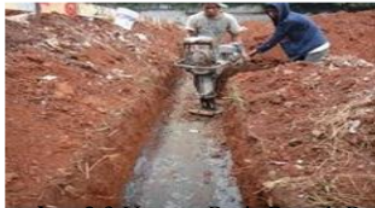
Gambar 2.3 Urugan Pasir Bawah Pondasi
