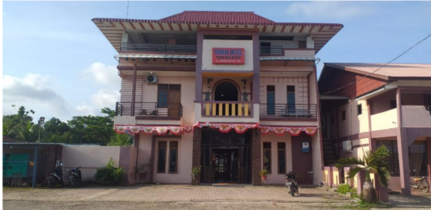
Lampiran 1: Foto Dokumentasi 1. Foto dokumentasi Hotel Yonnas
