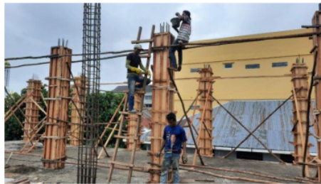
Gambar 2.6 Pekerjaan Kolom
