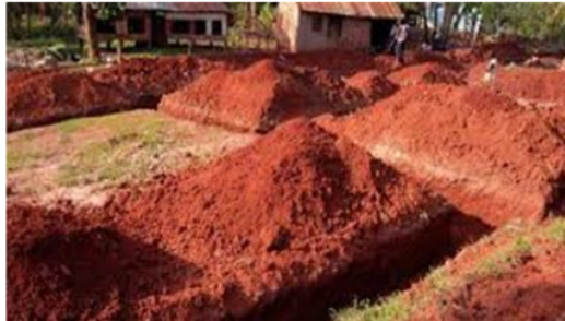
Gambar 2.2 Pekerjaan Tanah dan Pasir
