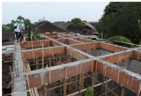
Gambar 2.7 Pekerjaan Ring Balk
