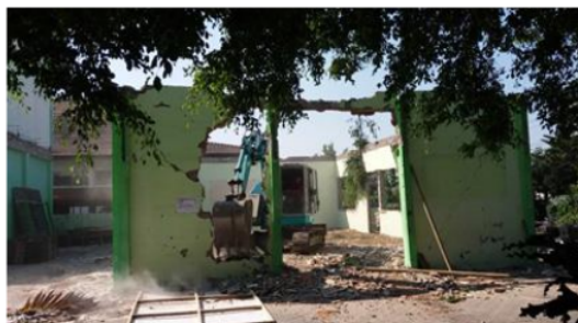
Gambar 2.1 Pembongkaran Gedung Lama
