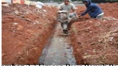
Gambar 2.3 Urugan Pasir Bawah Pondasi
