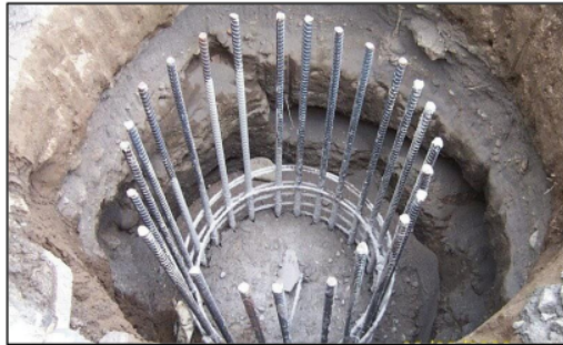
Gambar 2.15 Beton Siklop (pondasi sumuran)
