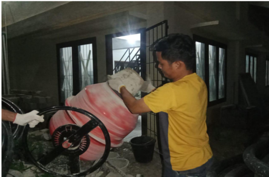
Proses pencampuran beton menggunakan mesin molen
