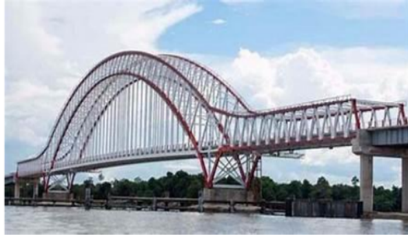
Gambar 2.15 Jembatan Baja (Sumber, https://4.bp.blogspot.com/ )
