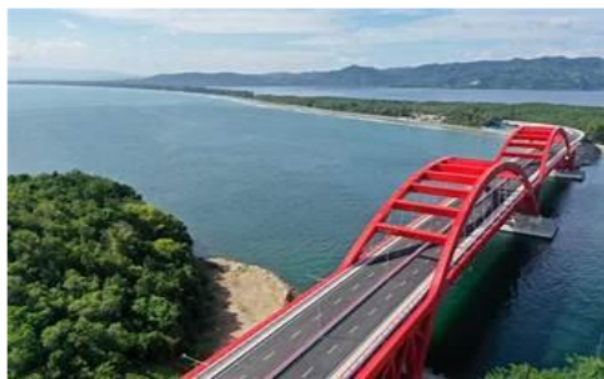
Gambar 2.12 Konstruksi Jembatan (Sumber, https://www.menpan.go.id/ )
