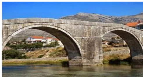
Gambar 2.14 Jembatan Pasangan Batu dan Batu Bata (Sumber, https://tse1.mm.bing.net/ )
