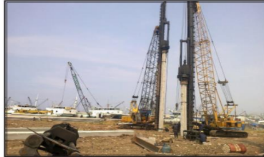
Gambar 2.3 Pemasangan Pondasi Tiang Pancang
