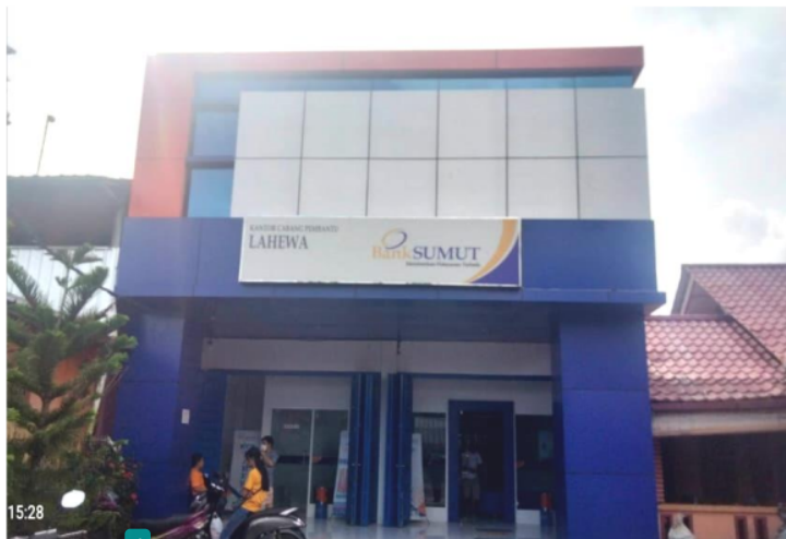
Gambar 4.1 PT. Bank Sumut Kantor Cabang Pembantu (KCP) Lahewa
