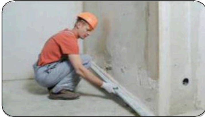
Gambar 2.4 Aplikasi jidar pada plesteran dinding
